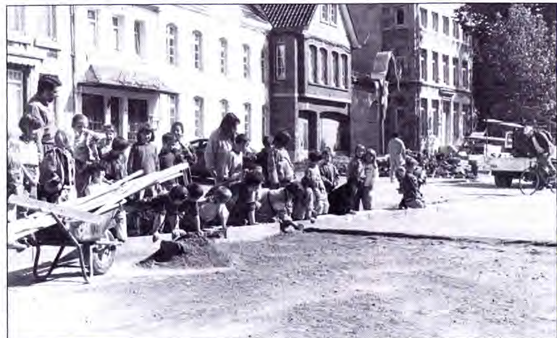
Anschauungsunterricht beim Straßenbau betrieben das erste und zweite Schuljahr der Städtischen Primarschule Unterstadt gestern nachmittag.
