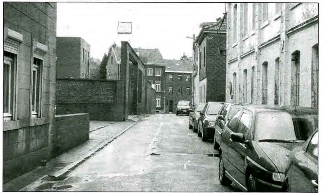
Die Heggenstraße hat eine Aufmöbelung dringend nötig. Nach erfolgtem Ausbau wird sie als Wohnstraße ausgewiesen. Fotos: Helmut Thönissen
